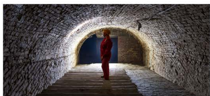
Visite accompagnate nelle gallerie sotterranee delle Mura
